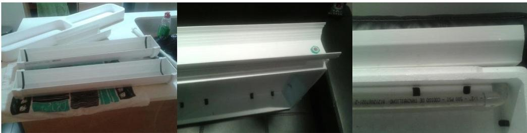
Después de instalar el sistema de riego y probarlo se procede a hacer el llenado del módulo con el medio de cultivo y luego se tapa con la malla geotextil que no permite que el medio se salga y actúa como soporte para las plantas de agua y nutrientes.
