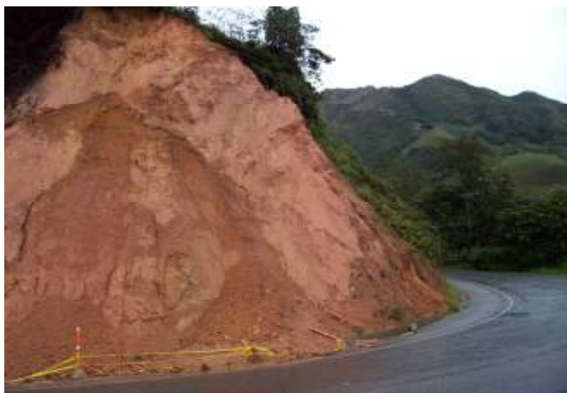
Foto No 5: Deslizamiento en la vía, trayecto Barbosa Don Matías
