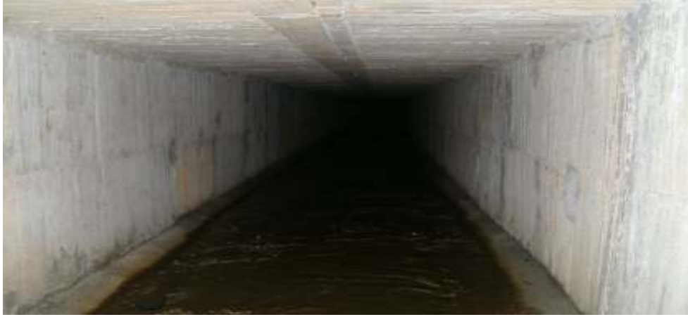
El "Box culvert" por dentro
