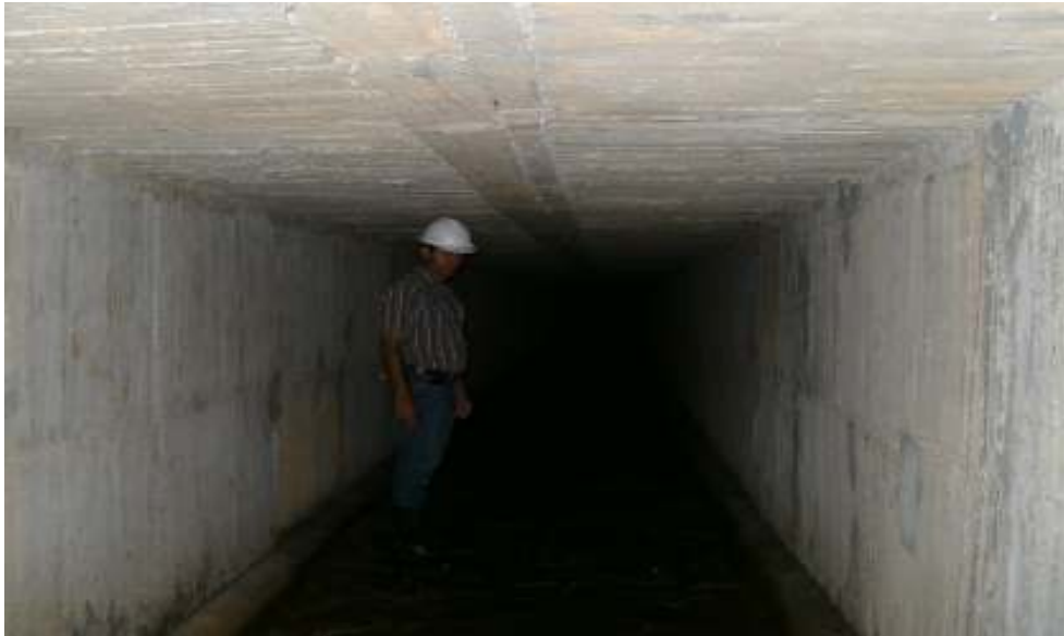
Dimensiones del espacio confinado
