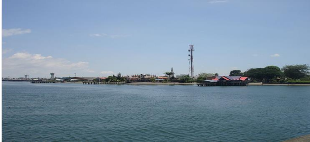
Figura 3. Panorámica puente del morro Tumaco
