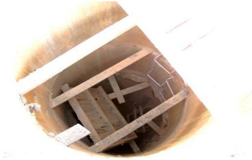
Una entrada al “Box colver”, obstaculizada con entibados, y con utilería, más no señalizada ni cubierta adecuadamente, representa un peligro de caída para cualquiera de los trabajadores y de accidente incluyendo maquinaria que pase por el lugar.
