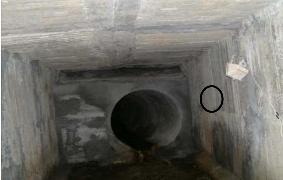
Iluminación, fallas en el sistema de iluminación por el aislamiento y protección de los cables, puede generar cortos, y hay riesgo de electrocución. La lámpara no se encontraba conectada en el momento a una fuente de energía.
