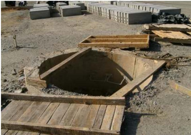
Carencia de seguridad y señalización insuficientes e inadecuadas
