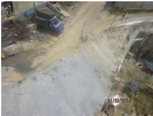
3. Protección de talud
